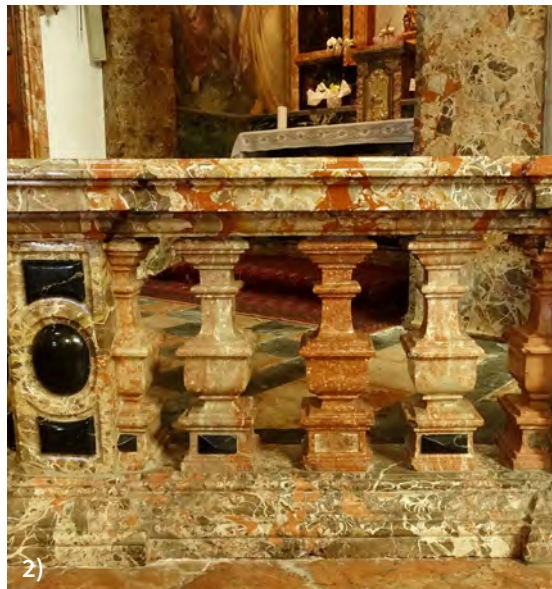
2) In der Kirche von Arzo – fast alles Arzo-Gesteine. Die Säulen der Chorbalustrade sind aus Broccatello, der Rest sind Macchia Vecchia-Brekzien.
