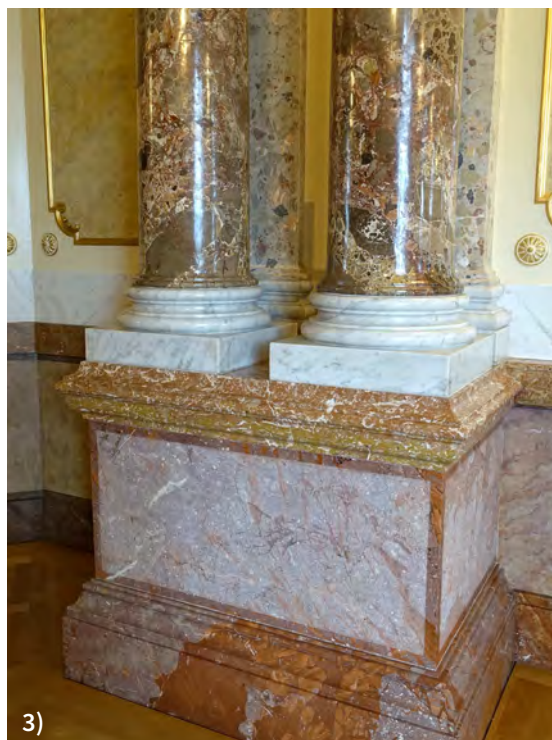
3) Detail aus der Wandelhalle des Bundeshauses. Sockel aus Broccatello, Säule aus Macchia Vecchia.
